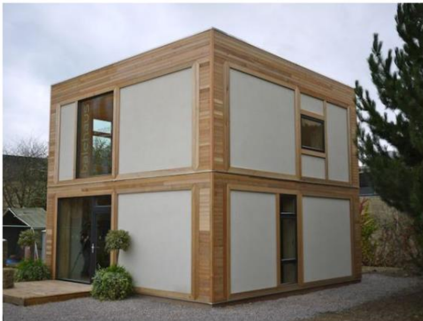
Рисунок 1 – Каркасный дом из панелей, построенный британской компанией ModCell
