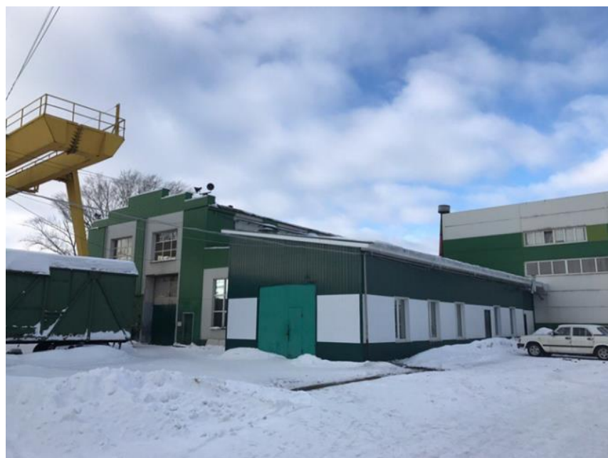
Рисунок 2 – Фотография вагонного депо, видовая точка Б
