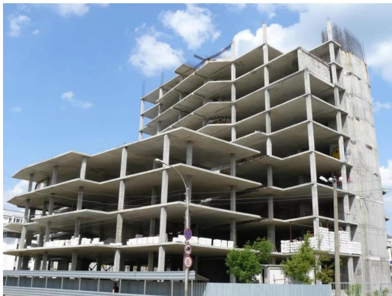
Рисунок 3 – Строящееся здание по технологии каркасного домостроения
