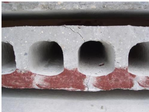
Рисунок 4 - Продольная трещина в плите, вид с торца
