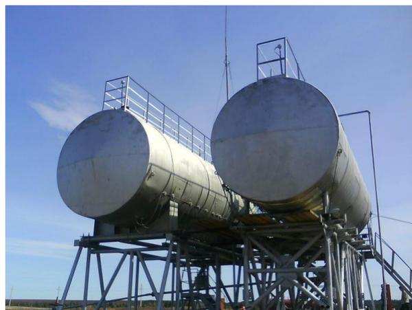
Рисунок 3 - Горизонтальные цилиндрические резервуары
