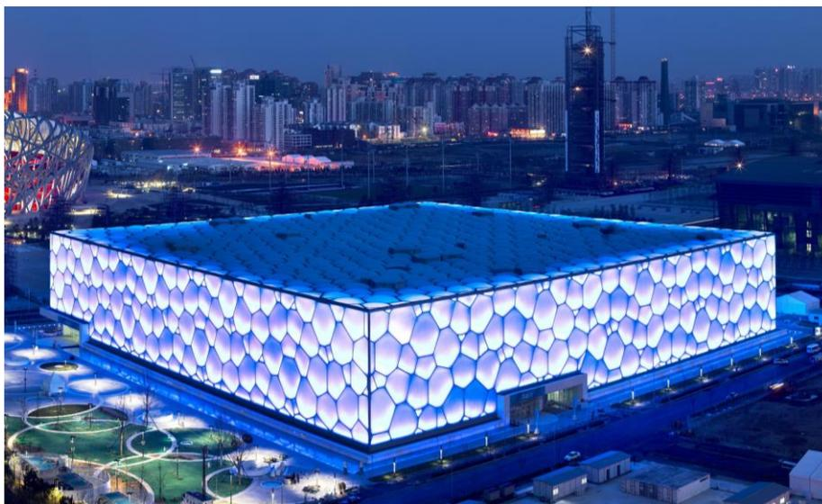
Национальный центр водных видов спорта, Пекин, покрыт оболочкой из этилентетрафторэтилена (ETFE) – долговечного пластика, используемого для крыш. Дизайн оболочки напоминает мыльные пузыри.
