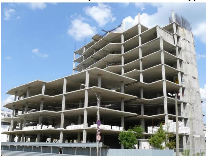
Рисунок 3 – Строящееся здание по технологии каркасного домостроения
