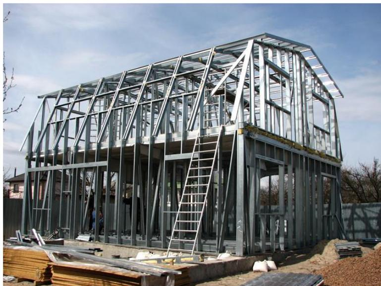
Рисунок 1 – Пример стального каркаса малоэтажного дома
