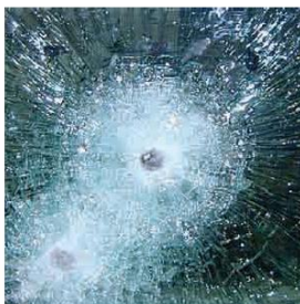
Рис. 1. Пример разрушения ламинированного стекла.
