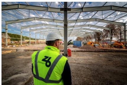
Рисунок 2 - Зал технического обслуживания для ÖBB Technische Services Ltd. в Санкт-Пёльтене.
