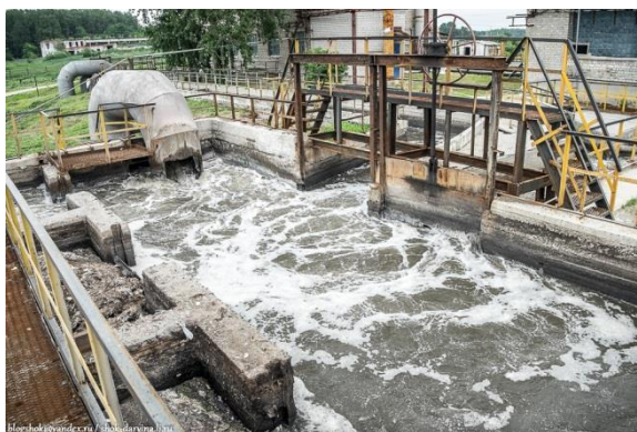
Рисунок 1– Поступление воды в песколовку [2]
