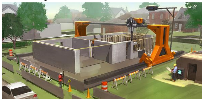
Рисунок 2 – Работа 3 D - принтера Contour Crafting
