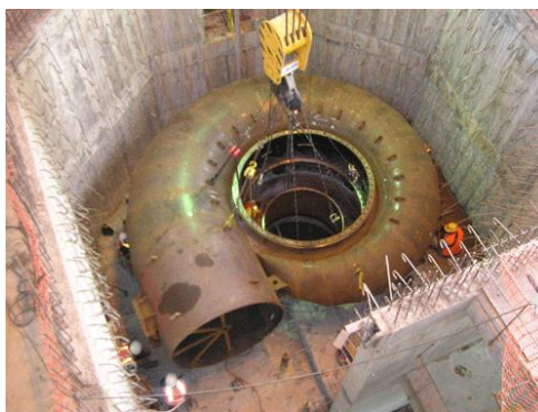
Рисунок 3 – Радиально-осевая турбина длиной.
