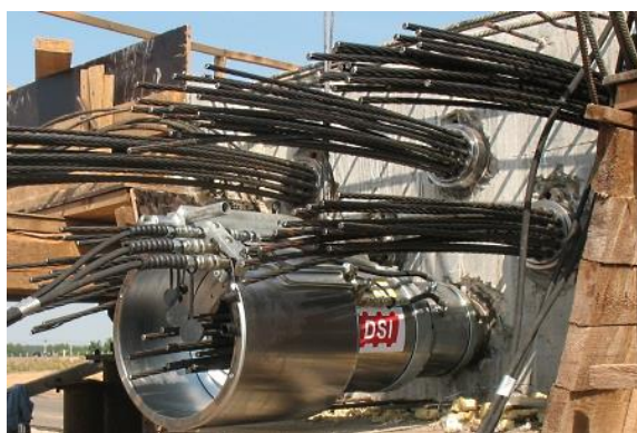
Рисунок 3 – Преднапряжение канатной арматуры со сцеплением с бетоном
