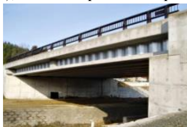
Рисунок 3 – Автомобильный мост в Японии. В качестве пролетного строения моста применены балки с трапециевидно-гофрированной металлической стенкой и железобетонными поясами
