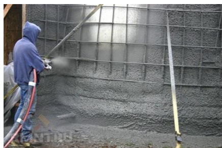
Рисунок 1 – Торкретирование купольной поверхности
