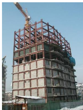
Рисунок 1 - Многоэтажное здание с использованием SIN -балок
