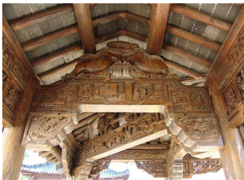
Рисунок 8 – Отсутствие потолочных перекрытий
