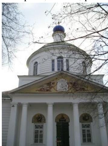
Рисунок 4 – Скорбященская церковь. Фасад
