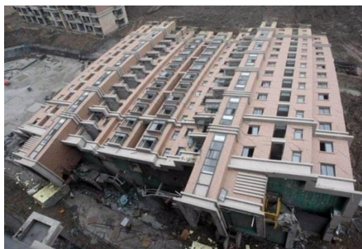
Рисунок 1 – последствия падения жилого дома в Шанхае.
