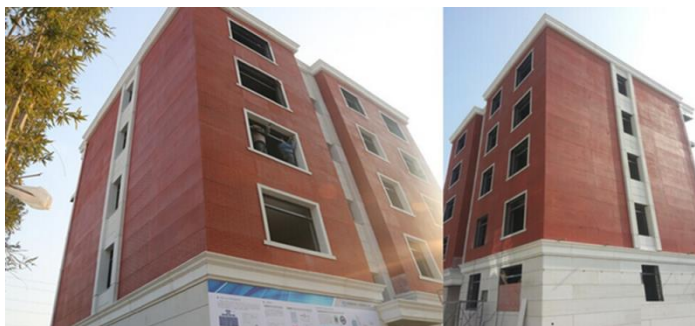
Рисунок 1 – Напечатанный пятиэтажный дом в Китае
