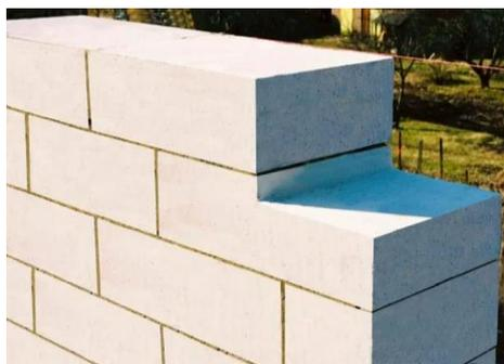
Рисунок 2 – Блок газосиликатный.
