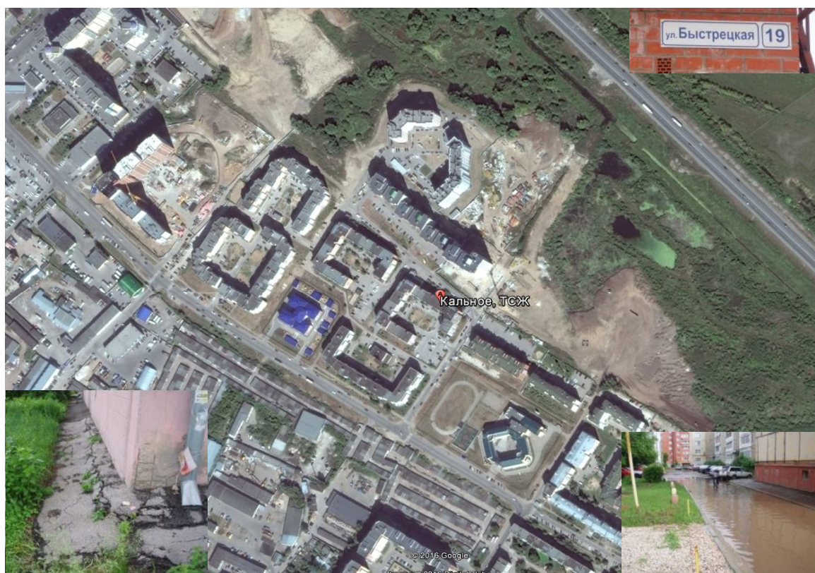
Рисунок 1 – Микрорайон «Кальное». На вставках показано затопление улиц и состояние отмостки у некоторых домов
