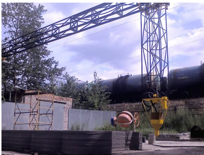
Рисунок 1 – Строительный трёхмерный принтер компании «СПЕЦАВИА»
