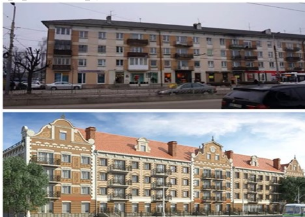
Рисунок 1 – Жилой дом до и после реконструкции.
